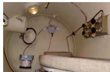
Рис. 3. Поглотитель CO2, панель для подключения кислородных масок внутри барокамеры компрессорной Figure 3 Carbon Dioxide Absorber, Mask Enabling Panel inside Pressure Chamber in Compressor Room
