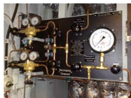
Рис. 4. Пульт подачи кислорода в барокамеру с возможностью дозированной подачи Figure 4 System of Air Supply to Pressure Chamber with Possibility of Dosed Supply
