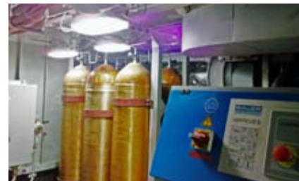
Рис. 1. Компрессоры и баллоны-воздухохранители в трюмном помещении компрессорной Figure 1 Compressors, Cylinders and Airtanks in Hold of Compressor Room
