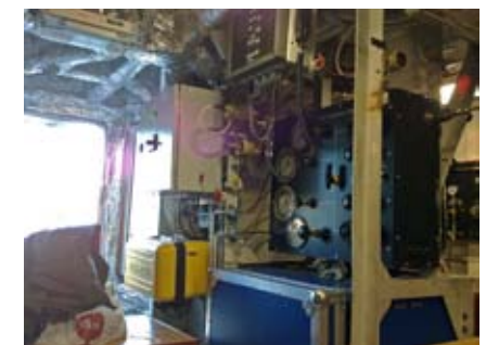
Рис. 7. Пульт подачи воздуха водолазам и телефонная станция с гелиевым корректором речи Figure 7 Panel of Air Supply to Divers and Telephone System with Helium Speech Corrector
